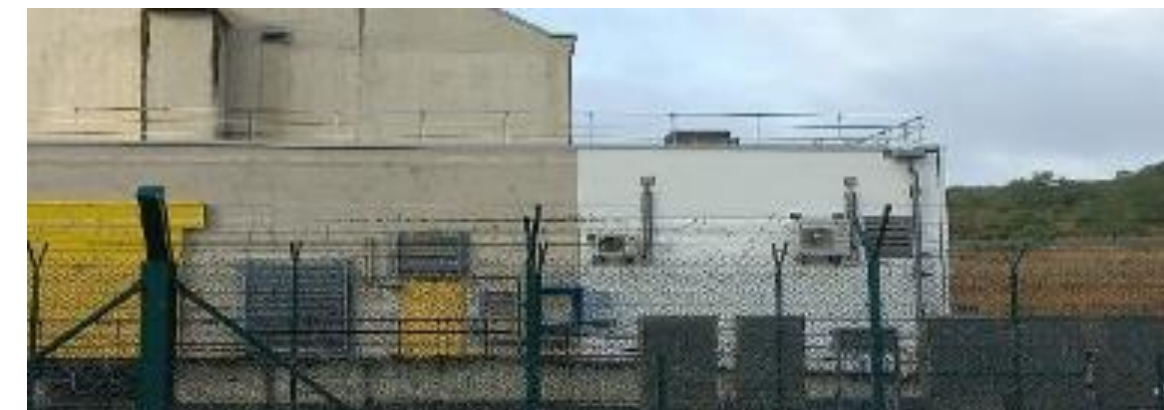
Local CVC bassin aéro SEC (Civaux)
