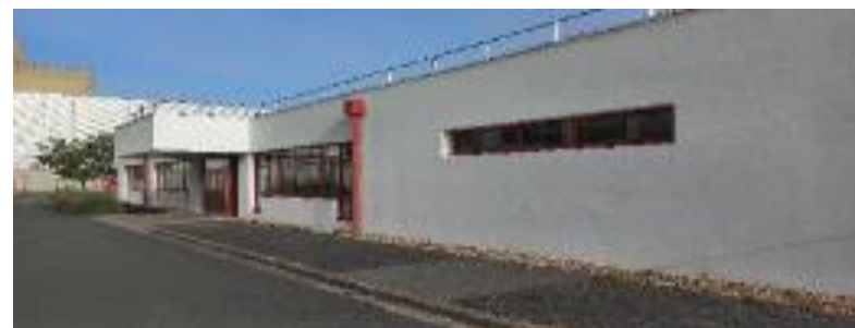
Local serveur informatique (Civaux)
