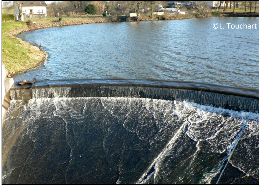
L'étang de la Pouge (87) et le déversoir de crue aux hautes eaux.
