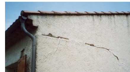
Maison fissurée en raison des mouvements de terrain induits par la rétractation et le gonflement du sol argileux. © BRGM
